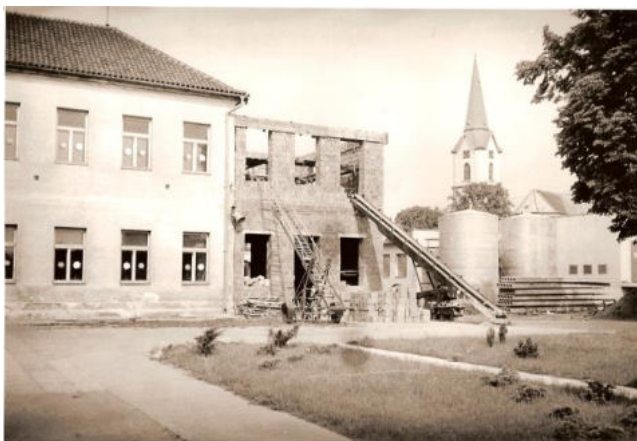
Dostavba kabinetů k původní školní budově
