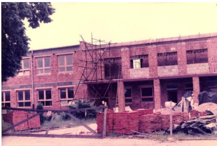
Výstavba školní jídelny a tříd prvního stupně
